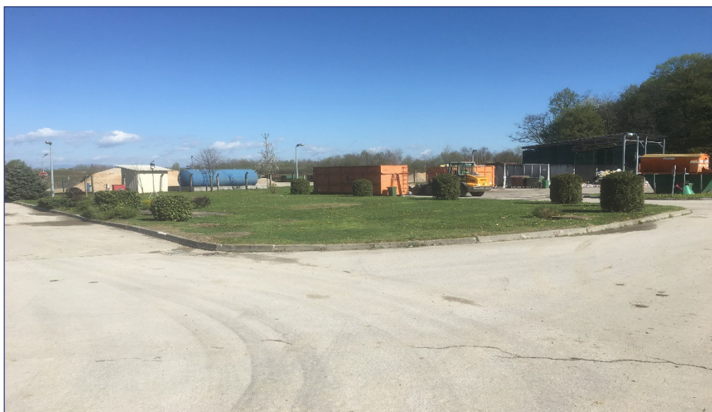
Slika 6: Predprostor reciklažnog dvorišta na odlagalištu »Beljavine«
