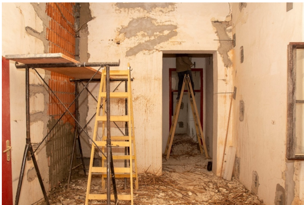
Slika 43. Radovi obnove u OŠ Topolovac
