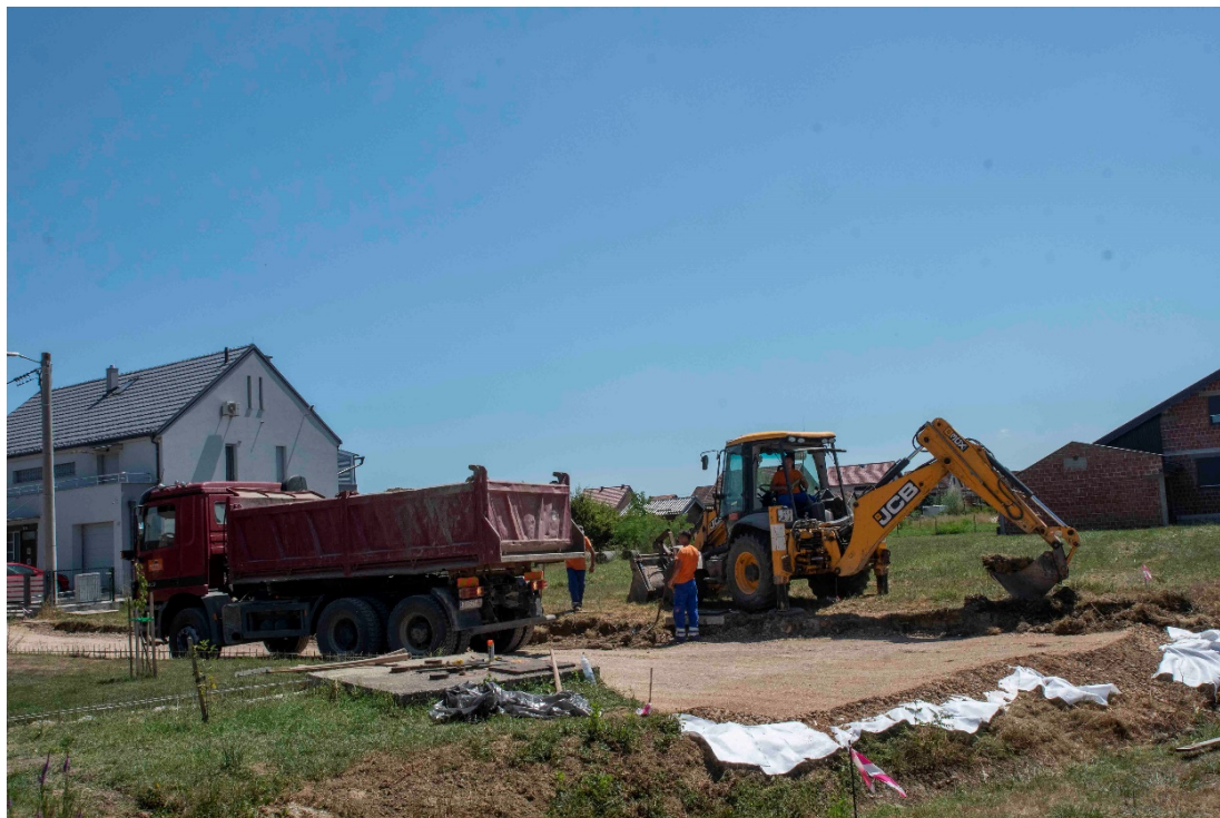
Slika 25. Pripremni radovi na Slavonskoj i Turopoljskoj ulici
