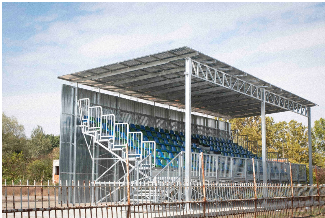
Slika 34. Nove tribine na stadionu Metalac
