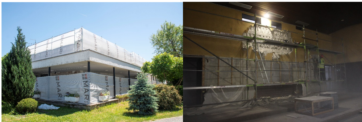
Slika 47. Radovi na Kazalištu-21
