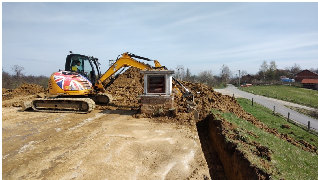
Slika 60. Radovi sanacije štete na vodocrpilištu Novo Selište
