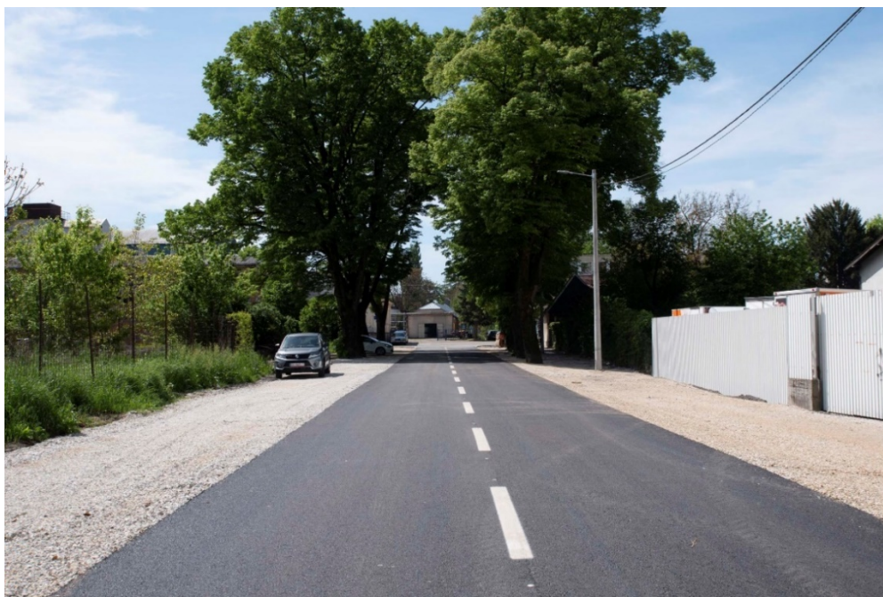
Slika 20. Sanirana prometnica u Ulici Vatroslava Jagića
