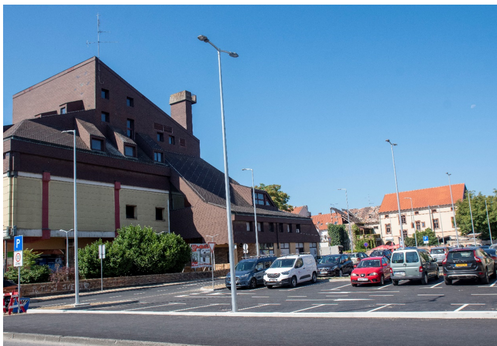
Slika 51. Završeni radovi na parkiralištu kod GRAME
