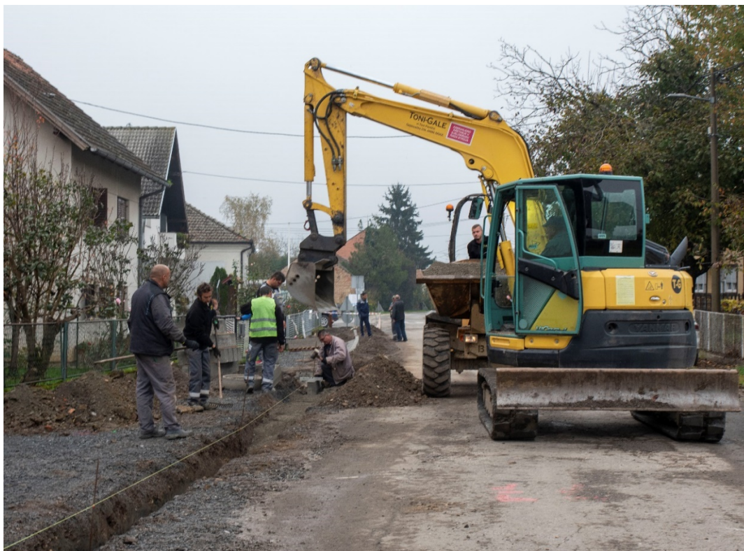
Slika 54. Greda - radovi na proširenju kolnika i izgradnja nogostupa
