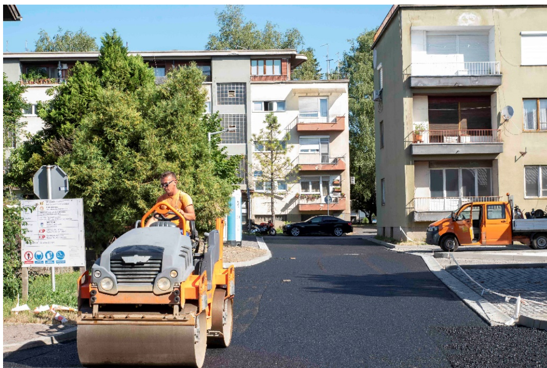
Slika 24. Radovi na Trgu hrvatskih branitelja
