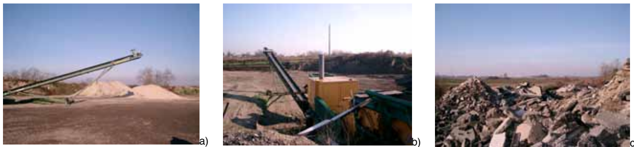
Slika 11.: Mobilno postrojenje za oporabu građevinskog otpada na lokaciji Ivanovec-Preloge
