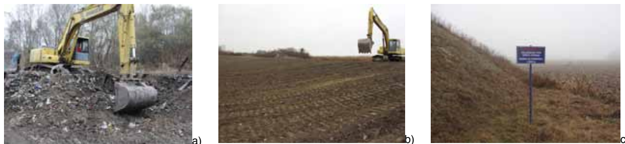
Slika 18.: Sanacija površine onečišćene otpadom na lokaciji „Jacine“
