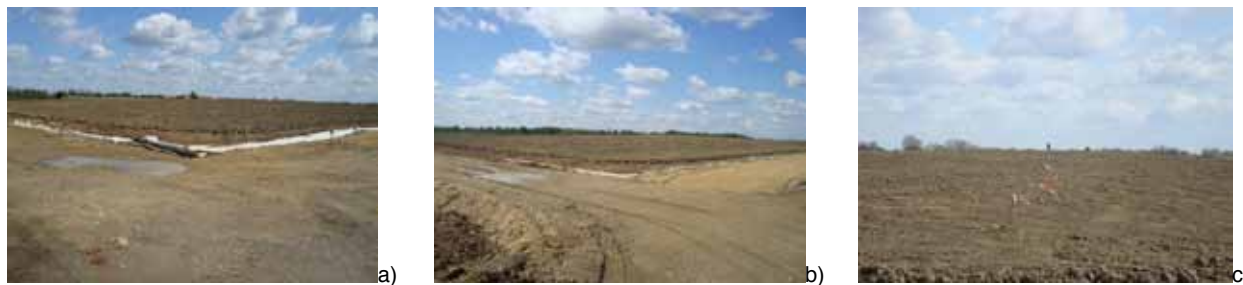
Slika 16.: Sanacija površine onečišćene otpadom na lokaciji „Gorice“
