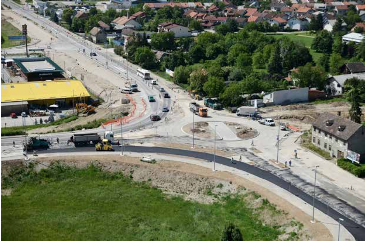
Slika 7: Gradnja novog kružnog toka (rotora) na spoju Zagrebačke ulice s mostom Gromova te Bakranovom ulicom
