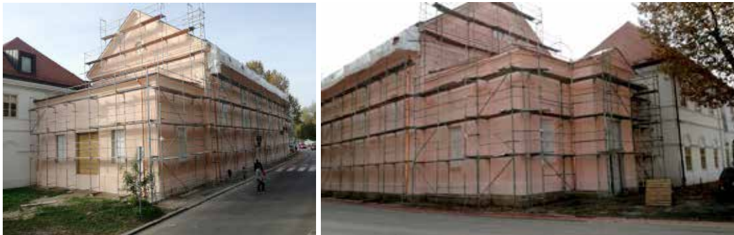
Slika 12: Dopršetak sanacije prigradnje uz Veliki Kaptol u Sisku
