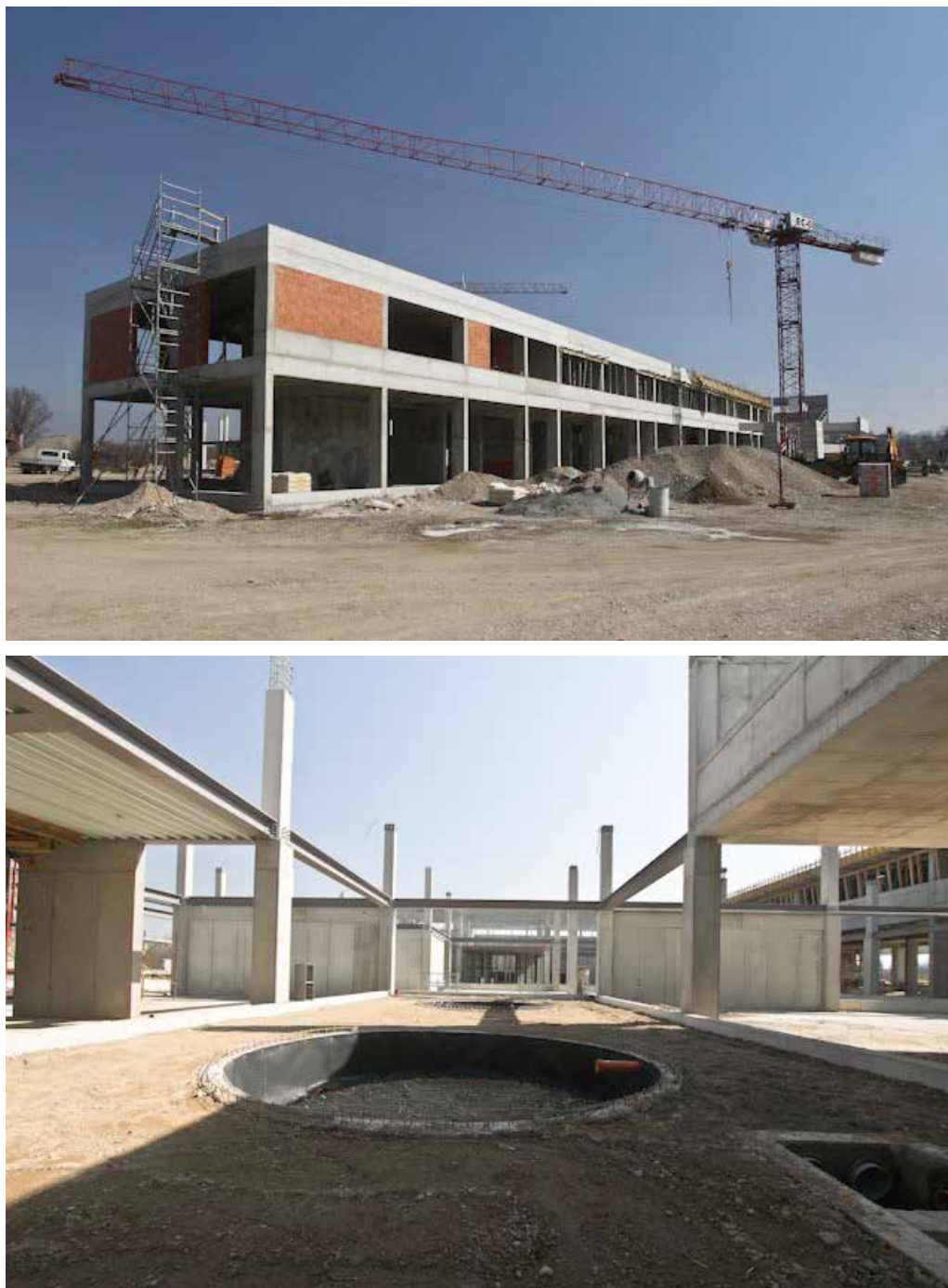
Slika 15: Gradnja nove obrtničke škole u Sisku
