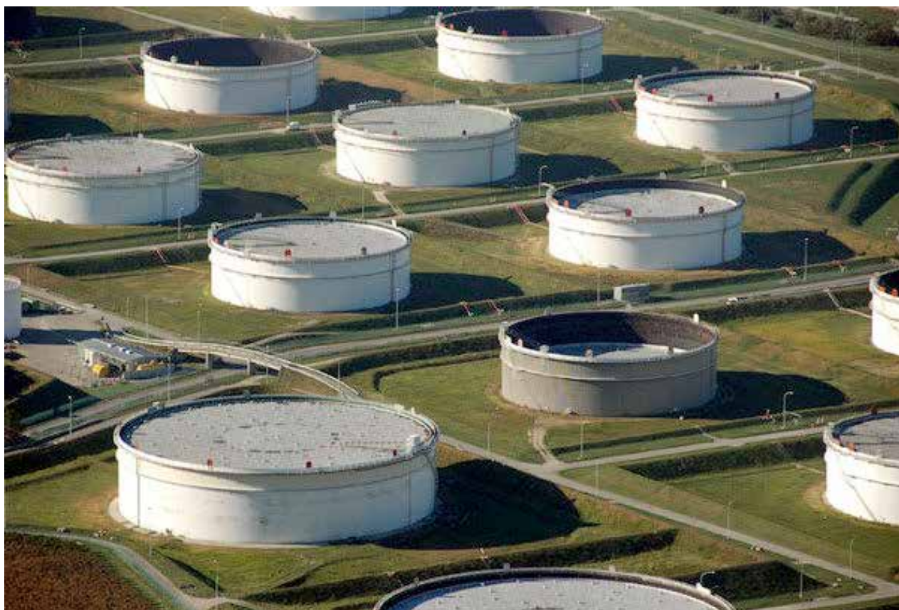
Slika 5: Izgradnja novog rezervoarskog prostora JANAF d.o.o.
