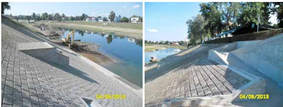
Slika 28: Gradnja pristana za turističke brodove uz obalu središta Siska
