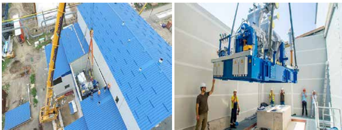
Slika 6: Gradnja kogeneracijske bioelektrane - toplane (BE-TO)
