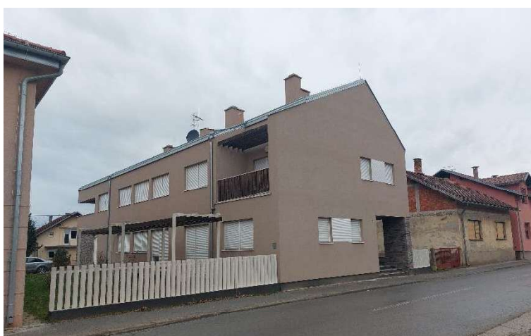
Slika 51. Izgrađena zgrada za stambeno zbrinjavanja u Jasenovcu
