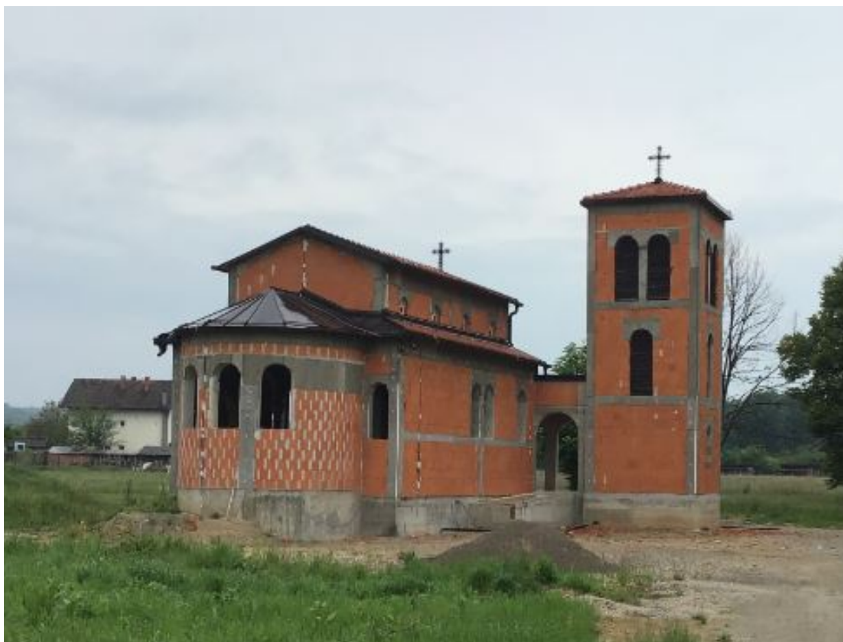
Slika 8: Pravoslavna crkva u Vrginmostu u izgradnji
