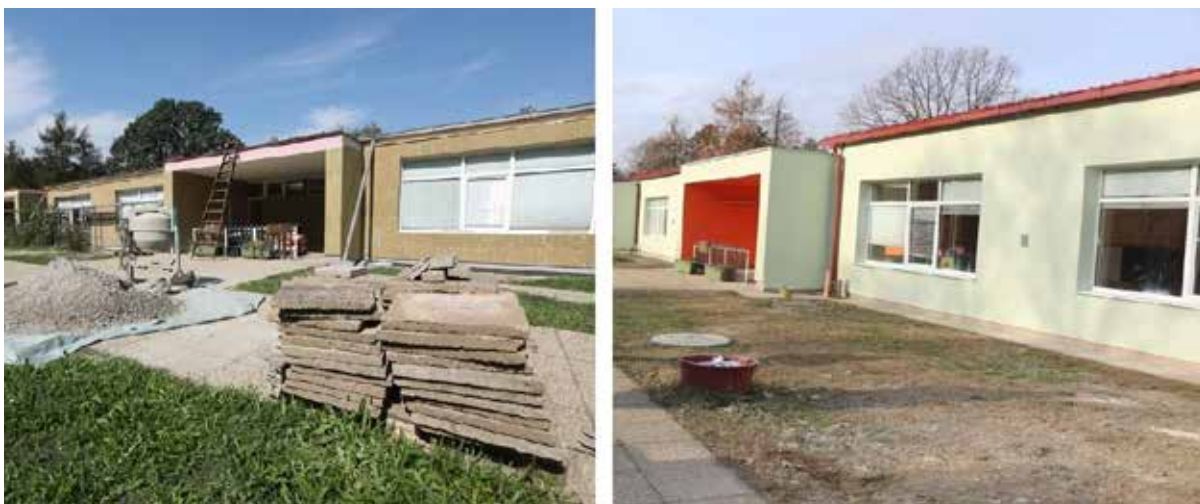
Slika 66 Energetska obnova vrtića u Varaždinu
