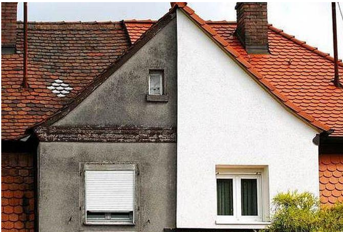
Slika 67 Primjer energetske obnove kuće
