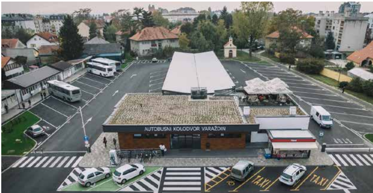
Slika 65 Obnovljeni autobusni kolodvor u Varaždinu
