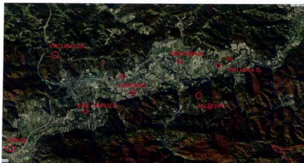
Slika 3. Lokacije »divljih odlagališta« na području Grada Varaždinske Toplice
