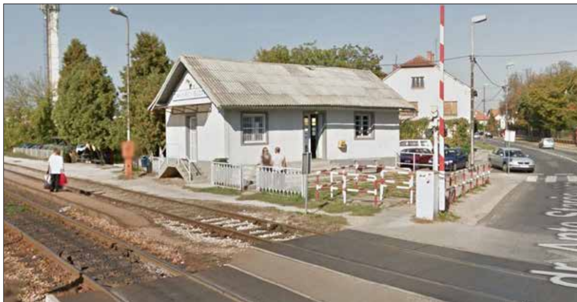
Slika 16.38. Željezničko stajalište Čakovec - Buzovec Izvor: Google maps
