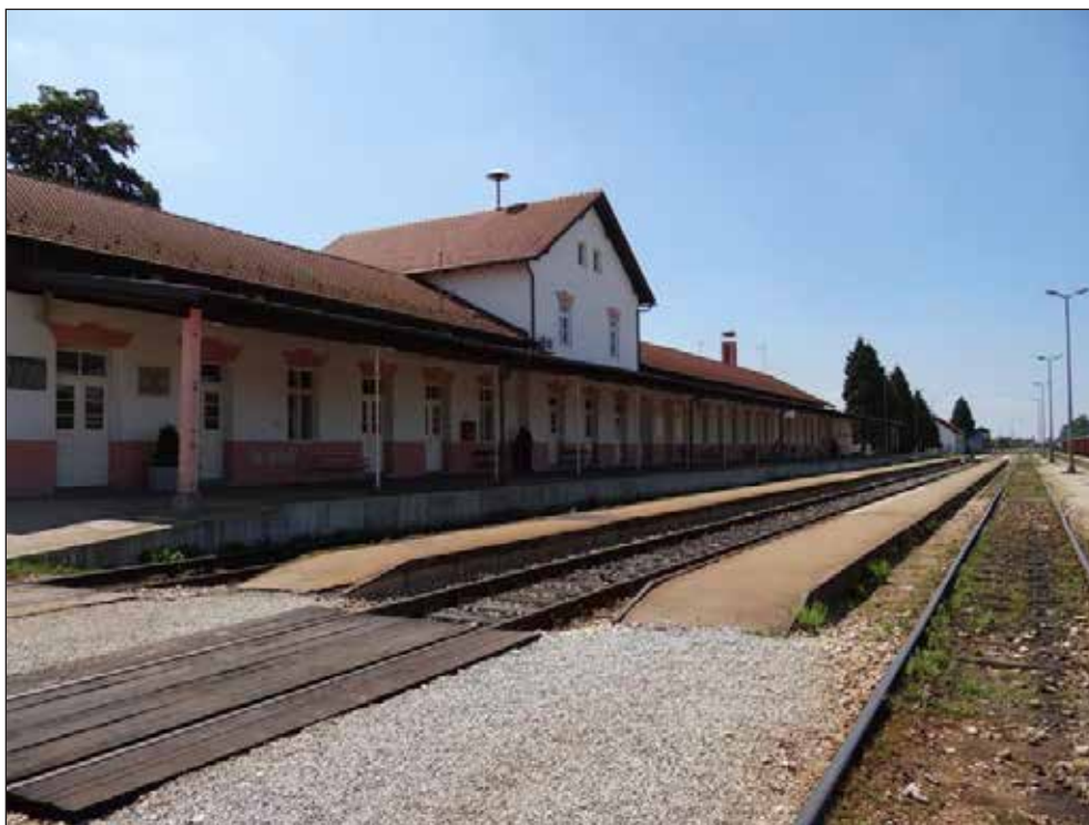
Slika 16.36. Željeznički kolodvor Čakovec
