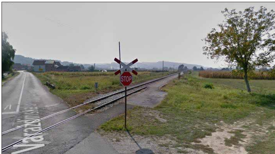
Slika 16.10. Željezničko stajalište Vidovec Izvor: Google maps
